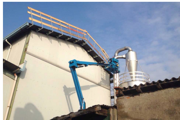
6. Montaggio parapetti con PLE
